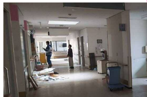
施設内被害状況の確認
