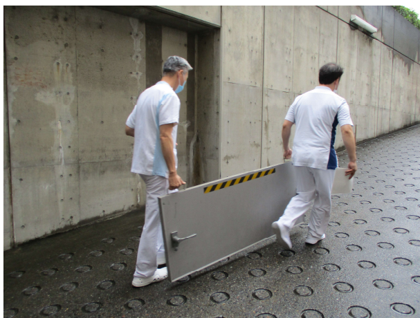
止水板移動中
